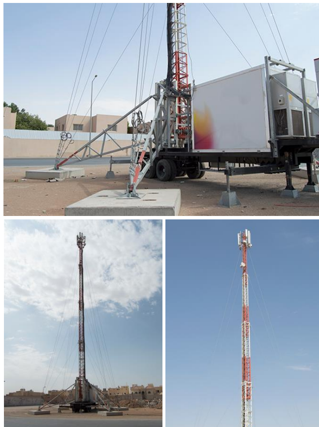
Slika 1. RDU – izgled i postavljanje [7]
